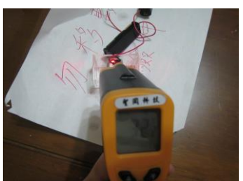
(23) 電線連接處 32.2 度
