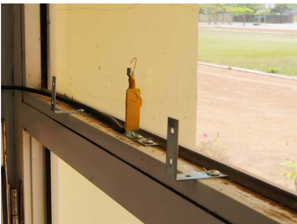
圖 7-1 將同軸電纜固定到教室的窗戶上
